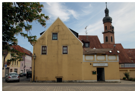
Abb. 4: Beispiel für eine Terrasse, die sich durch die gemauerte Brüstung besser integriert
