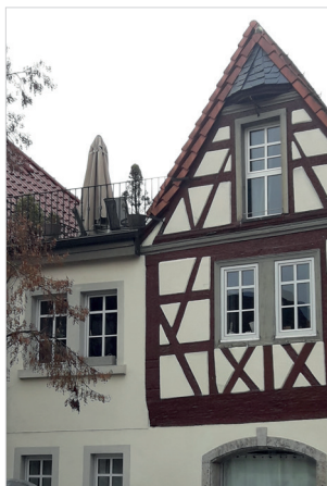
Abb. 3: Beispiel für eine Dachterrasse, die nicht stört
