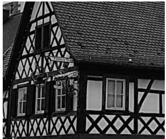
Abbildung 14: Freiliegendes Fachwerk
