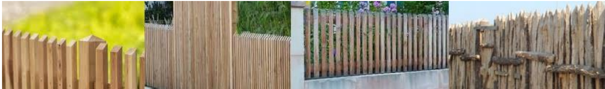
Abbildung 25: Holzzaunvarianten mit senkrechter Lattung
