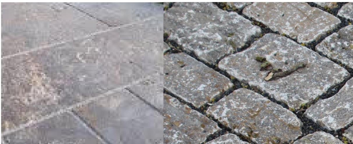
Abbildung 23: Natursteinbeläge aus Muschelkalk und Sandstein
