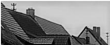
Abbildung 12: Kaminrohre über Dach
