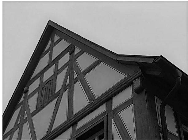
Abbildung 8: Dachvorsprung und Ortgang
